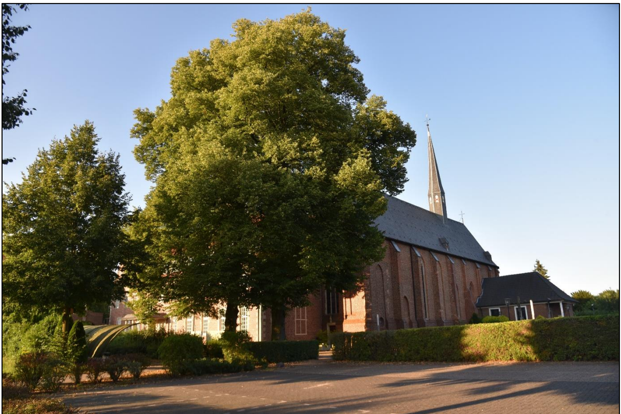
Abb. 5: Klosterkirche, im Vordergrund Parkplatz (Blickrichtung Nordosten).
