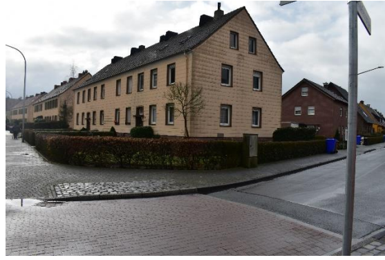
Abb. 3 Fassaden der Häuser Hawerkämpe 73, 71, 69, 67
